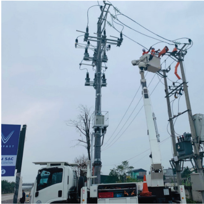
CÔNG TRÌNH TBA TRẠM SẠC CHXD NAM THÀNH
