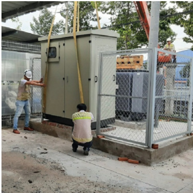
CÔNG TRÌNH TBA TRẠM SẠC CHXD VĂN PHƯƠNG
