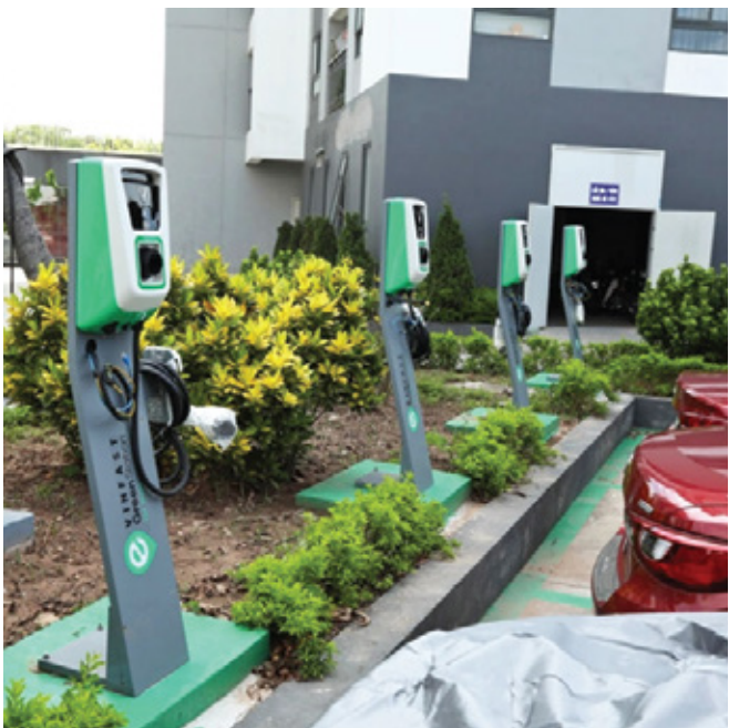
DỰ ÁN : VINCOM ƯƠNG BÍ - QUẢNG NINH
