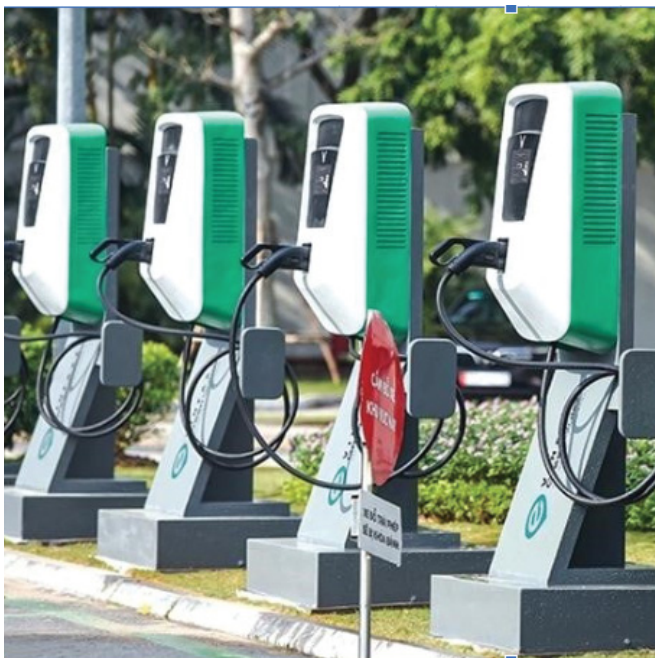
DỰ ÁN : VINHOMES TIMESCITY
